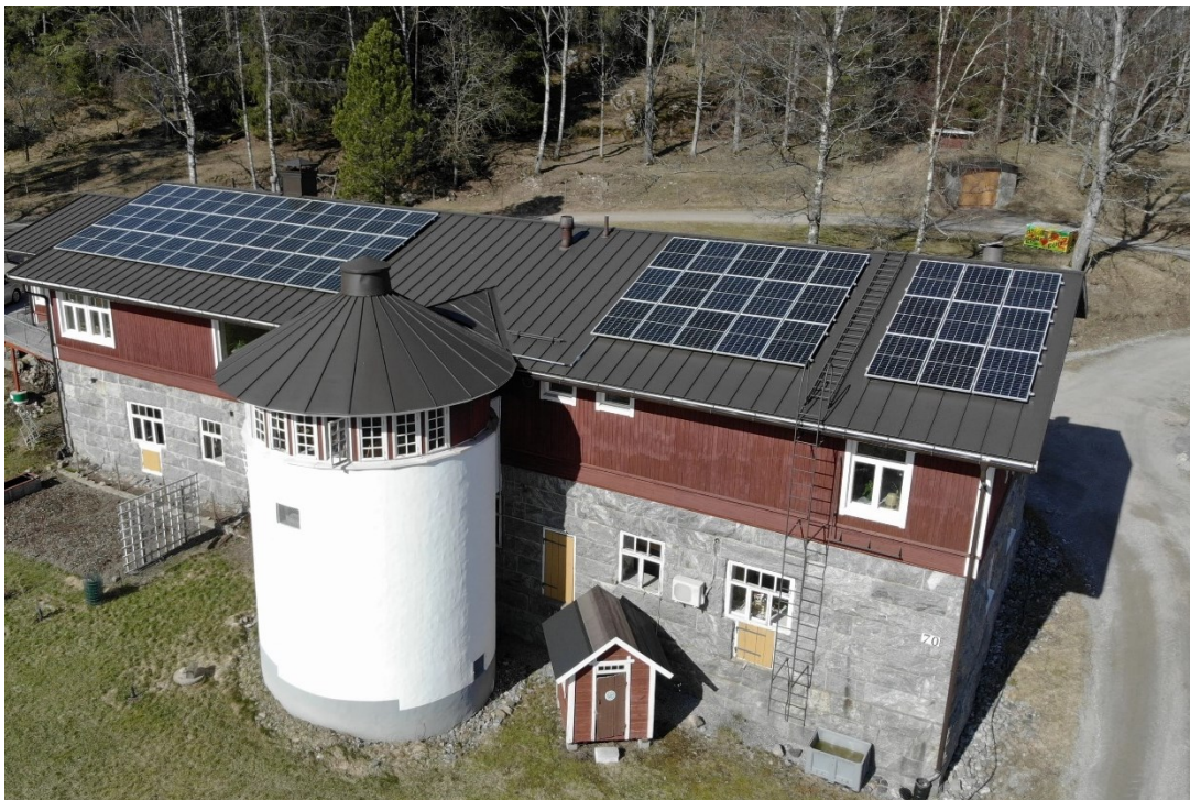
Kuva 1. Aurinkopaneelijärjestelmä maatalousrakennuksen katolle asennettuna. (1komma5, 2024)
