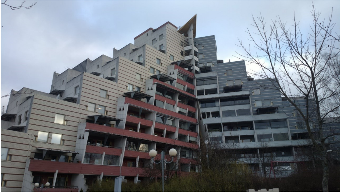
KUVA 33. Jallinojan suunnitteleman Pikku Huopalahden terassitalon toteutunut rakennus Helsingissä (Flickr 2014)
