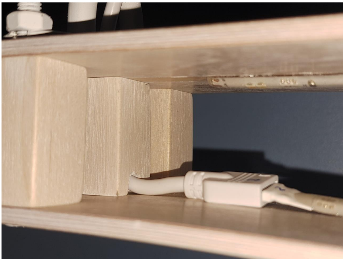
Kuva 14. Johdotuksen sai vietyä päädyn pilarien keskellä piilossa (2024).
