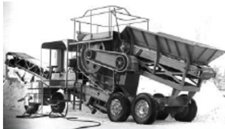
Kuva 3 Pyöräalustainen murskainlaitos, vuodelta 1959 /3/
