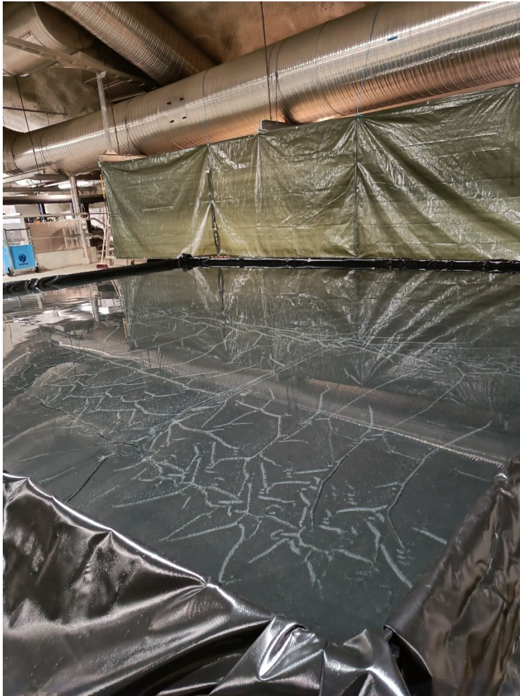
Kuva 1. Vesiallas koottuna ja vedellä täytettynä.
