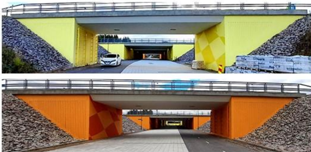
Kuva 37. Tunnelijonon päissä ovat erilliset itäinen ja läntinen tunneli. Keskellä neljä tunneliä ovat yksi kokonaisuus. (Kuvassa tilanne v. 2022 ylläpidon jälkeen).
