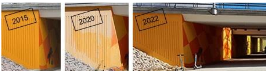
Kooste 50. Uhrautuva töhrysuoja on periaatteessa sekä mattaa että näkymätöntä, mutta tässä se oli samentunut maitomaiseksi.
