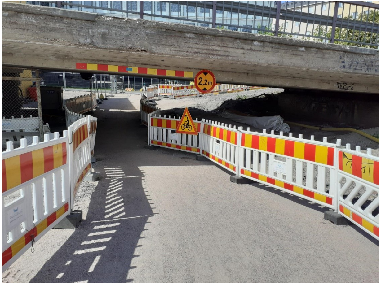
Kuva 12. Kruunusillat-hankkeen sillan tilapäinen alikulkuratkaisu (otettu Helsingin Hakaniemessä, henkilökohtainen tiedonanto, 2023).
