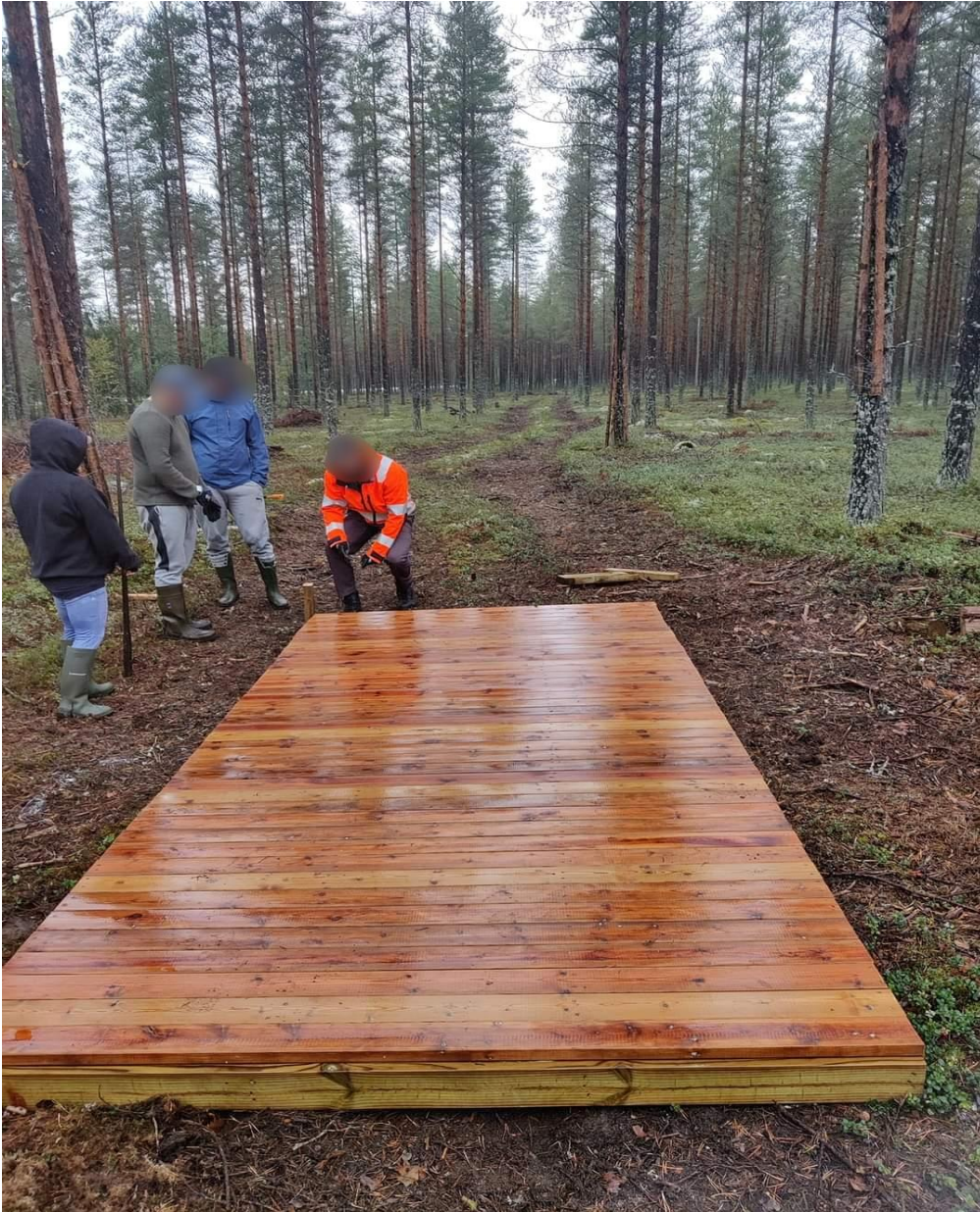
KUVA 4. Heittoalustan asentaminen maahan (Kela 2024)
