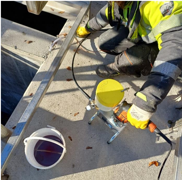
Kuva 27. Injektointityö käynnissä työturvallisuus huomioituna.
