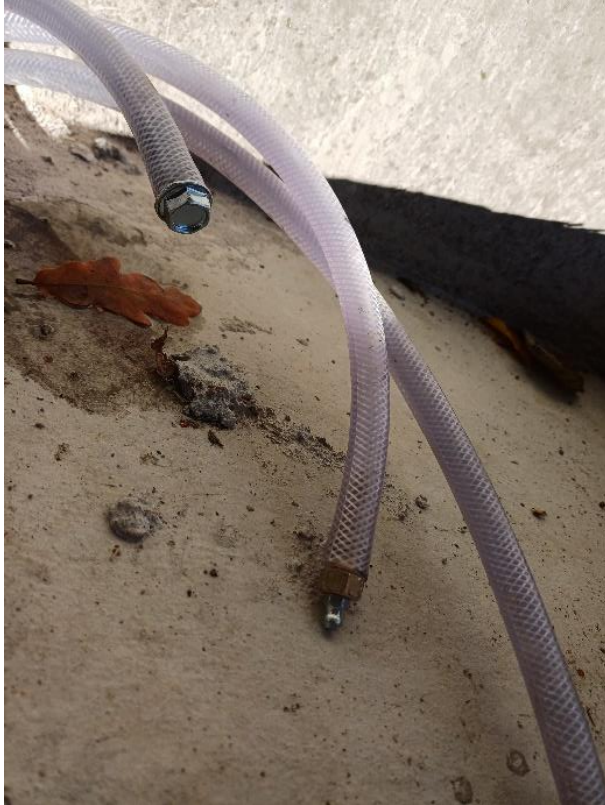
Kuva 26. Injektointiletkun päässä injektointinippa ja toisen letkun pää on tukittuna.
