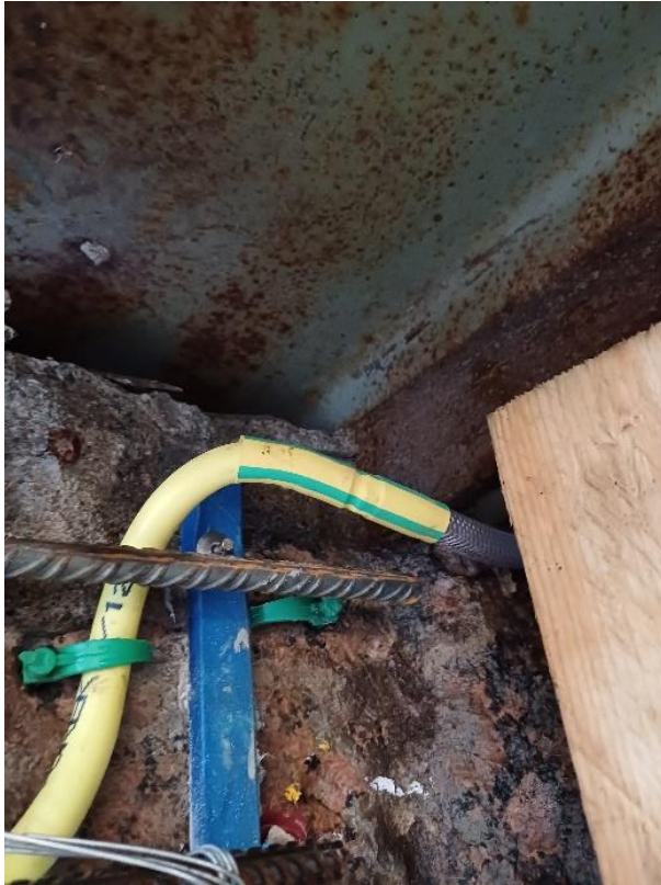
Kuva 24. Injektointiletkun ja syöttöletkun liitos varmistettu puristesukalla.
