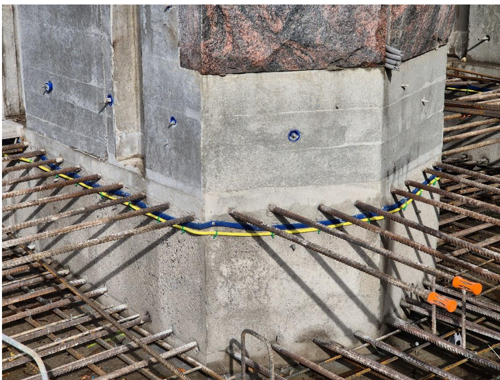
Kuva 19. Paisuva saumanauha kiinnitetty nauloilla betonin pintaan ja injektointiletku siihen tarkoitetuilla kiinnikkeillä.
