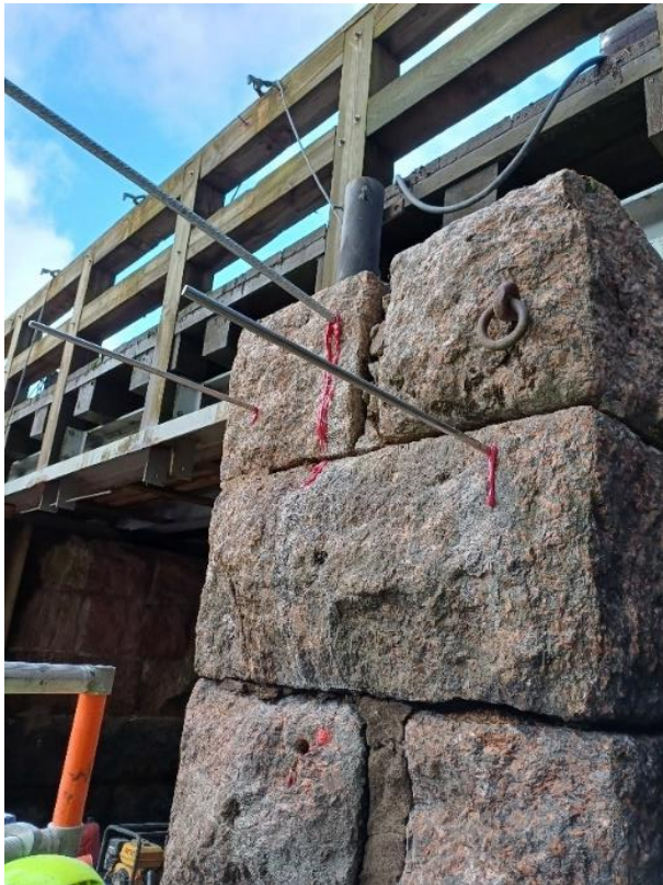
Kuva 5. Tartunnat asennettuna kemiallisella ankkurimassalla.
