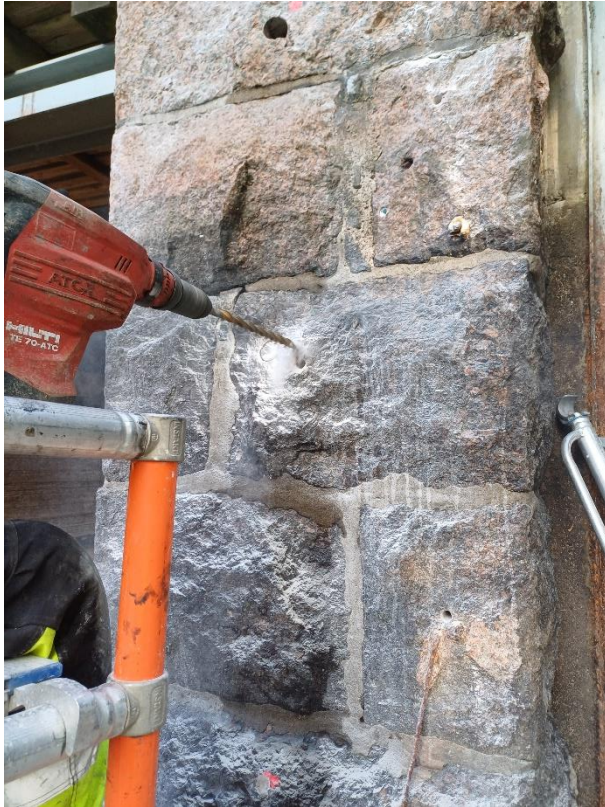
Kuva 1. Graniittikiveen reiän poraus poravasaralla, jossa kiviterä.
