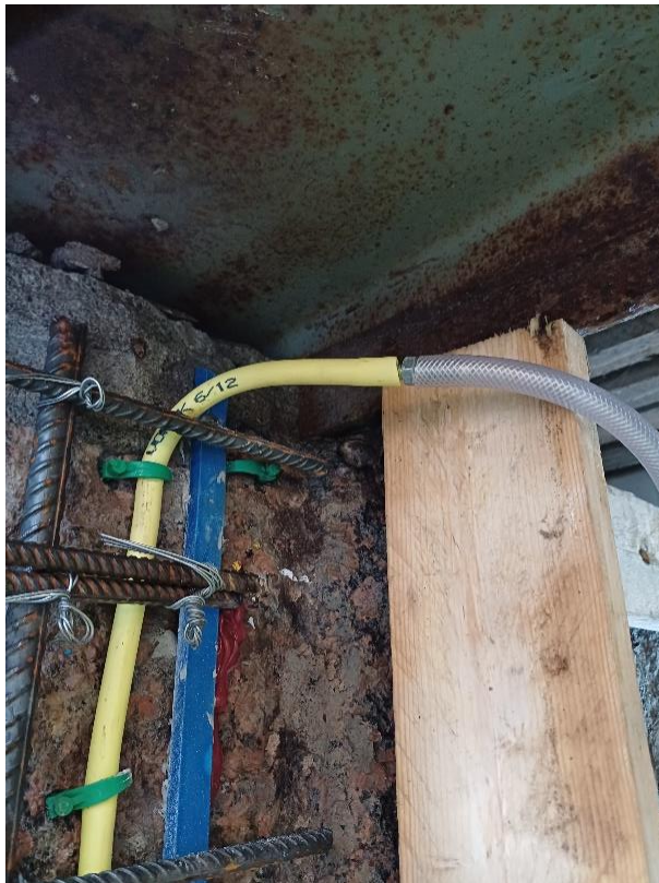
Kuva 23. Injektointiletku kiinnitetty liitoskappaleella syöttöletkuun.
