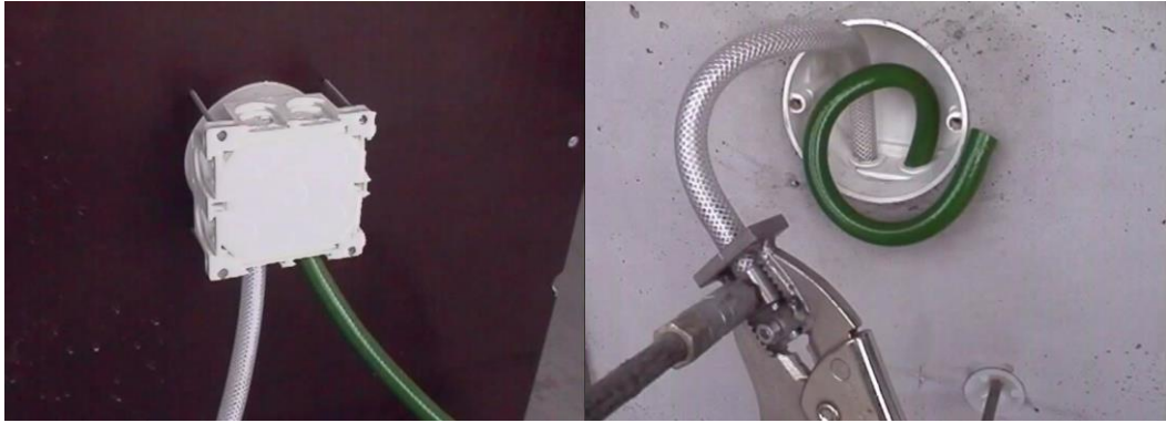
Kuva 22. Injektointiletkut asennettuna varausrasiaan. (Muottikolmio, n.d.)
