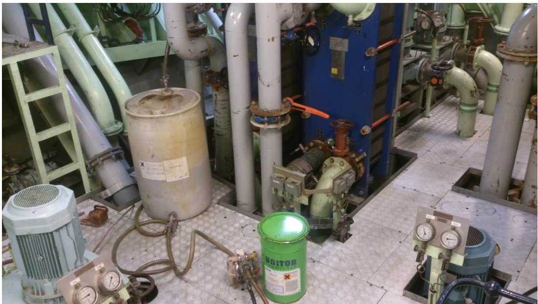
Kuva 8. M/T Purhan pesulaitteisto Wilden-pumppu sekä Descalex-pesuaine. (Olli-Ville Laine 2014)
