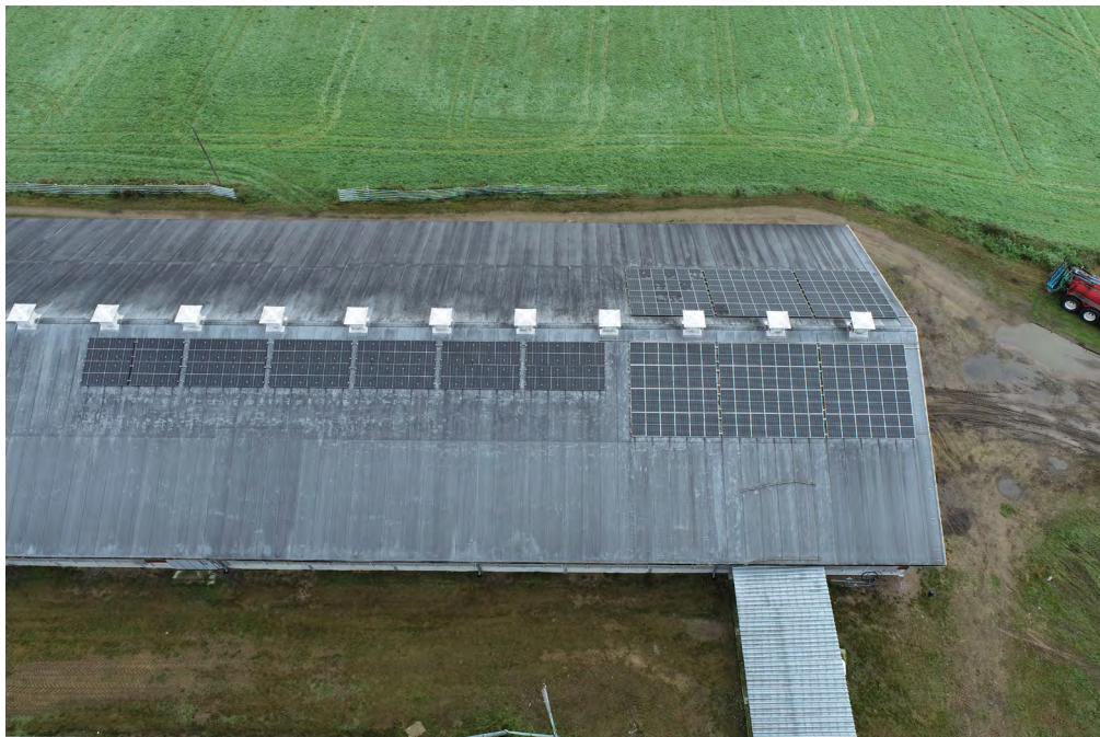
Kuva 1. Maatilan rakennuksen katolle on sijoitettu aurinkopaneeleita (kuva Henri Ket-tunen).
