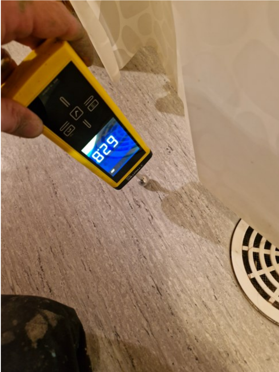
KUVA 15. Pintakosteusmittaus sisätarkastuksien yhteydessä
