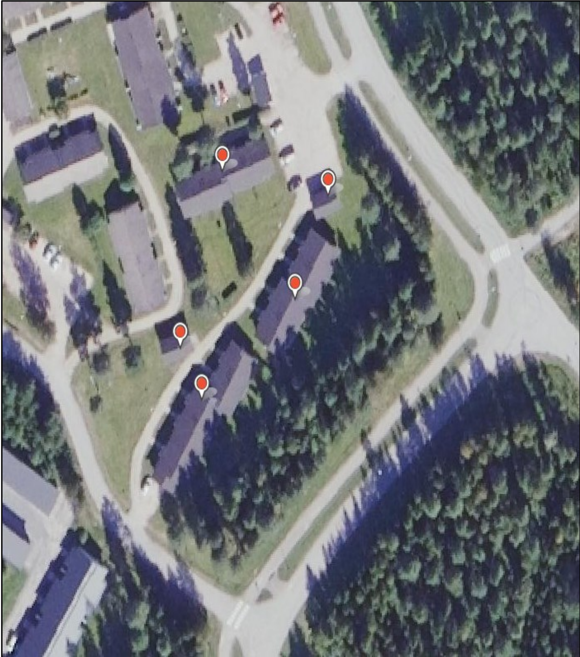
KUVA 11. Ilmakuva peruskorjattavasta kohteesta (15)
