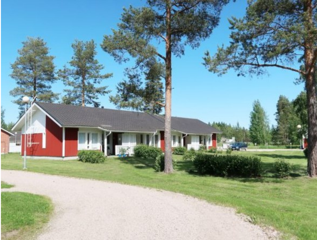
KUVA 7. Julkisivu kuva peruskorjattavasta kohteesta
