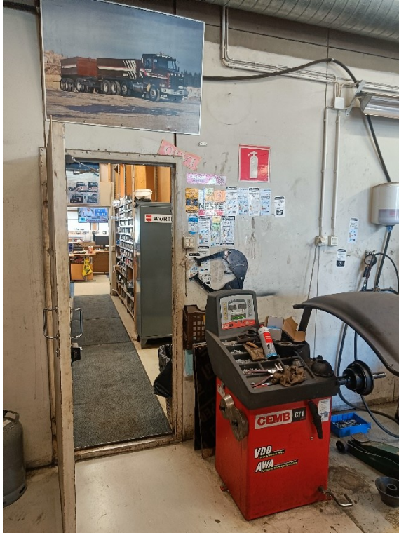
Kuva 6. Varaston oviaukko ennen
