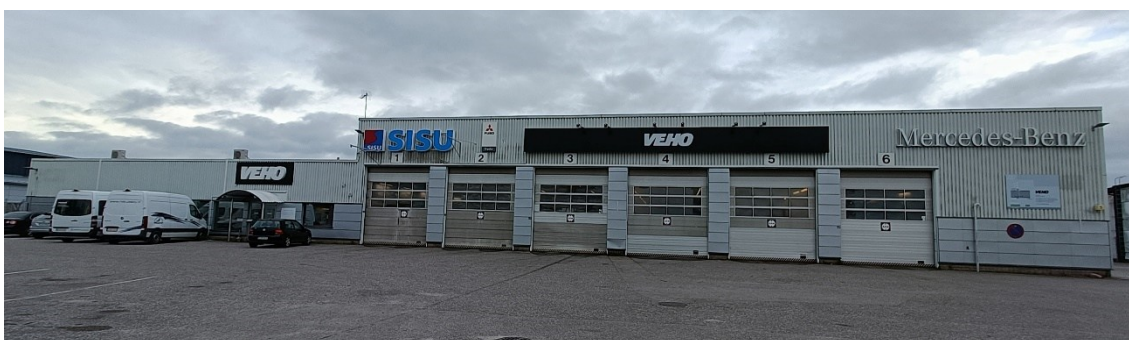
Kuva 1. Veho Salon julkisivu
