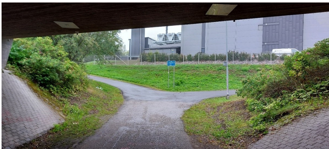
Kuva 36. Harvialantien alikulkutunneli kuvattuna itäsuunnasta.
