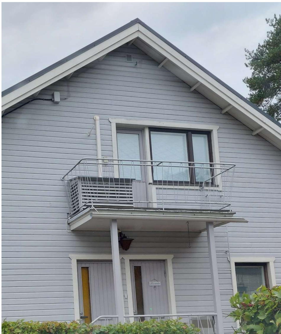
Kuva 12. Osittain runkoon tukeutuva parveke (Porrasmaa 2024).
