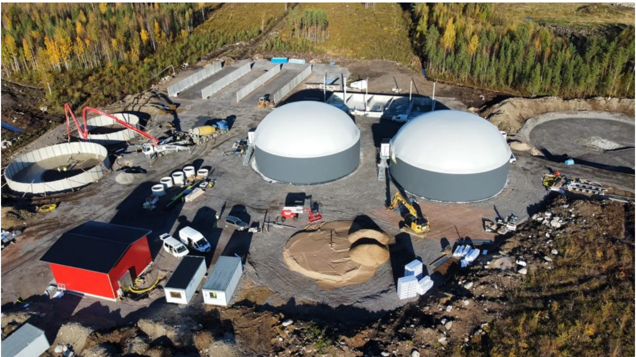
KUVA 2. Biokaasulaitos rakennusvaiheessa Pyhännällä (Latvaenergia, 2024).
