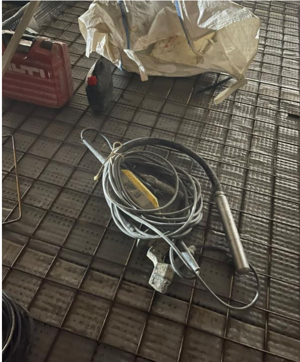
Kuva 8 Tärytin ilman poistamiseen [18.]
