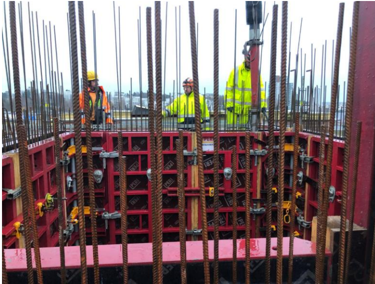
Kuva 13 Hissikuilun seinän valu. Betonipumpun letku upotettuna kokonaisuudessaan seinämuottiin. [18.]
