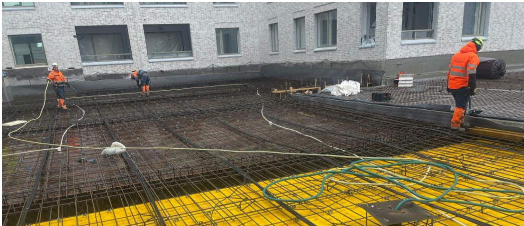
Kuva 6 Muotti- ja rauditustarkastuksen puutteiden korjaus ennen valua. [18.]
