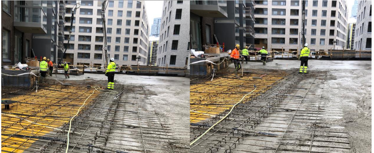
Kuva 10 Vasemmanpuoleisessa kuvassa betonia lasketaan muottiin ja korkoa tarkastetaan, jotta ei jouduta lapioimaan betonia pois. Oikeanpuoleisessa kuvassa betonia tasataan lastalla. [18.]
