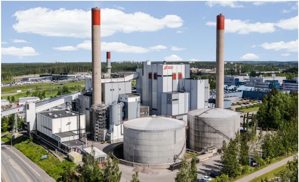
Kuva 1. Ilmakuva Vantaan Energian Martinlaakson CHP-voimalaitoksesta. [11.]
