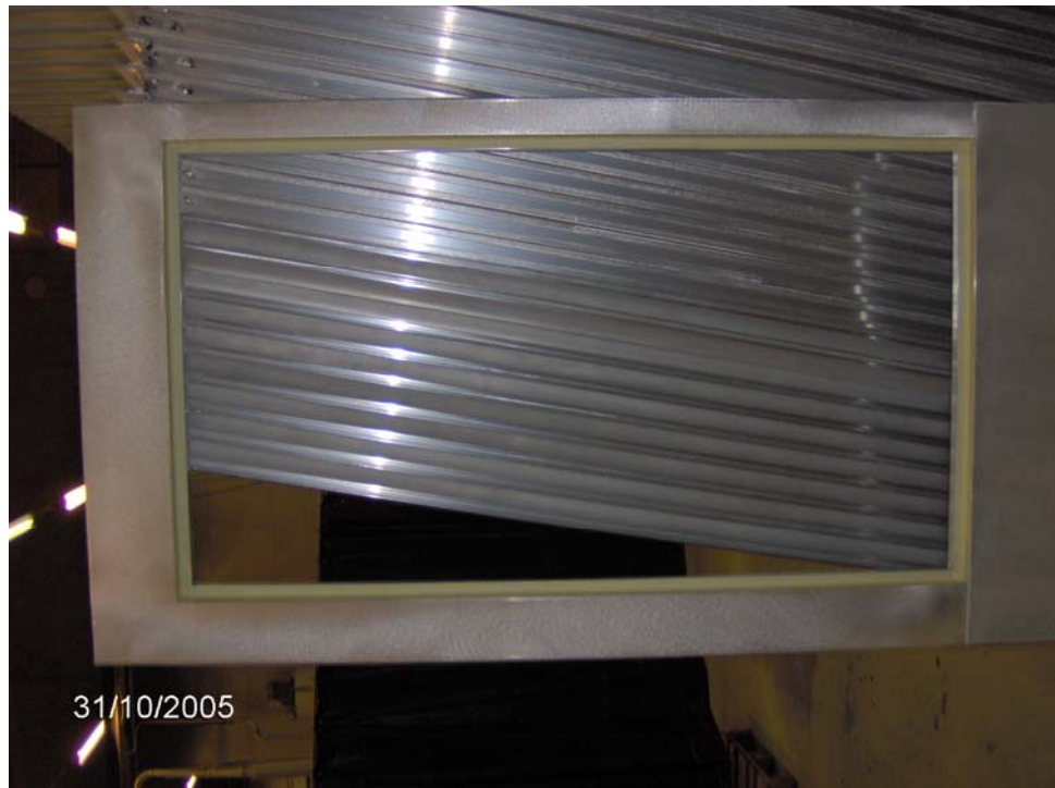
Kuva 3 Ikkuna aukko teipattuna
