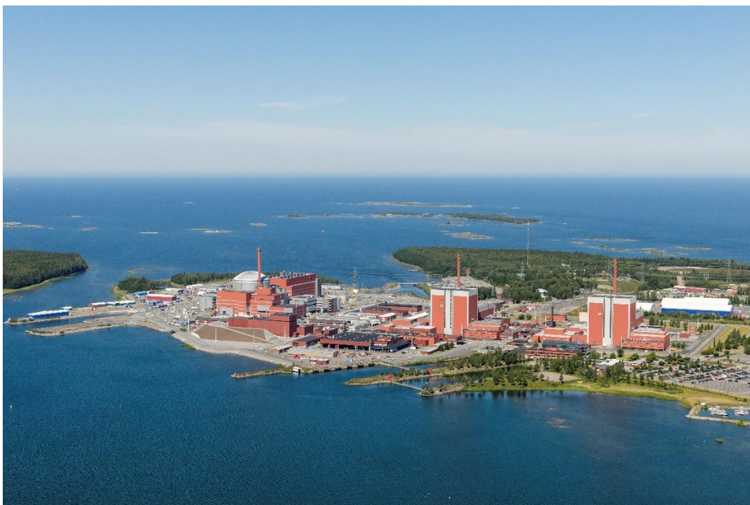
Kuva 1. Olkiluoto, vasemmalla OL3 keskellä OL1 ja oikealla OL2. (Teollisuuden Voima Oyj, 2024)
