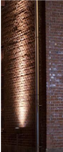
Kuva 29. Tiiliseinään suunnattu valaistus. Iguzzini 2014. Rajaus Laakkonen 2014.
