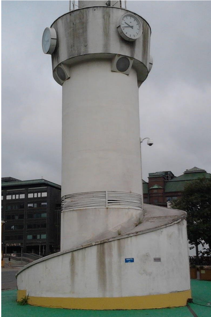
Kuva 5. Kellotornissa näkyvät valumajäljet. Jokinen 2013.
