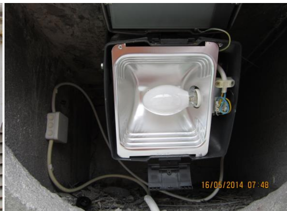
Kuva 24. Alavalaisimen sisältö valonlähteen. Lasipalatsin Mediakeskus 2014.
