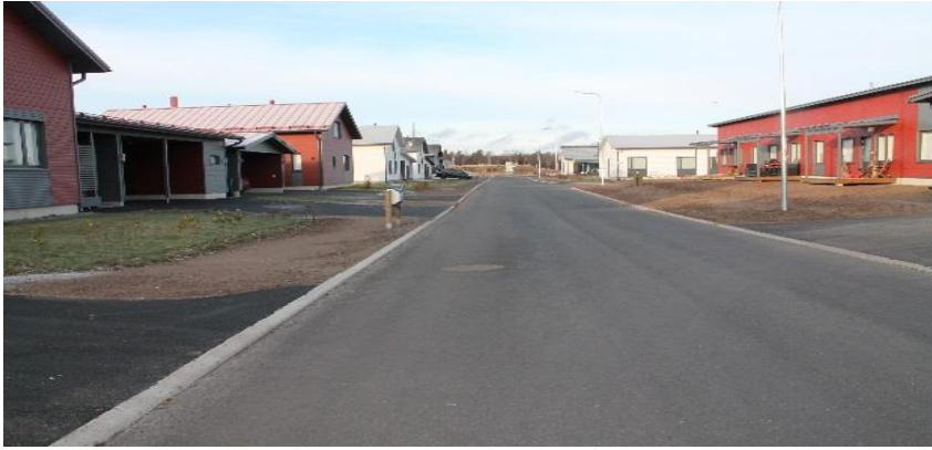
KUVA 25. Katu malalla liukuvalubetonireunakiveyksellä
