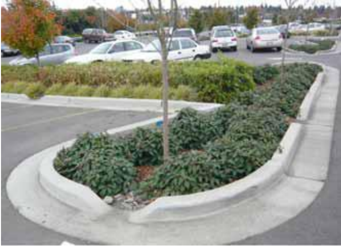
KUVA 17. Imeytyspainanne parkkipaikan reunassa (Kuntaliitto, linkit Tekniikka -> Hulevesien hallinta -> Hulevesiopus, 129)
