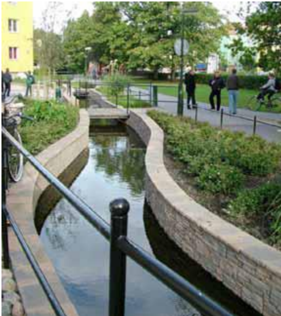
KUVA 19. Rakennettu kanava suurille vesimäärille (Kuntaliitto, linkit Tekniikka -> Hulevesien hallinta -> Hulevesiopas, 142)
