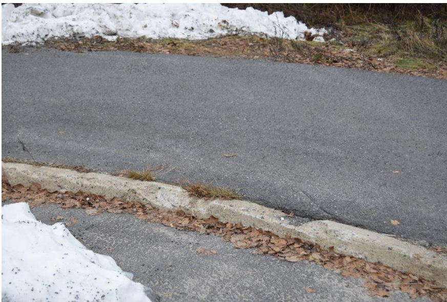
KUVA 27. Liukuvalettu betonireunakivi Äimäntieltä Oulusta
