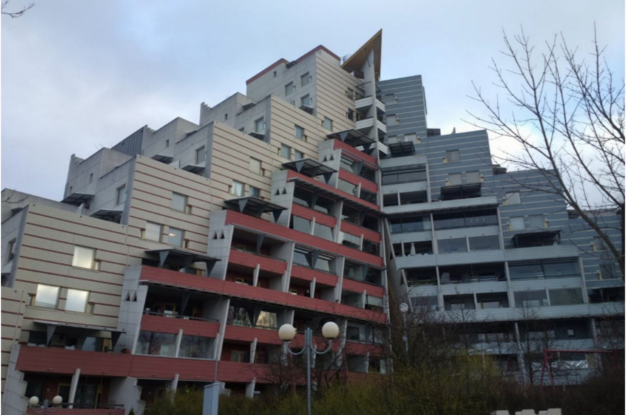
KUVA 3. Jallinojan suunnitteleman Pikku Huopalahden terassitalon toteutunut rakennus Helsingissä (kuva: hugovk/Flickr.com, 2014, CC BY-NC-SA 2.0).
