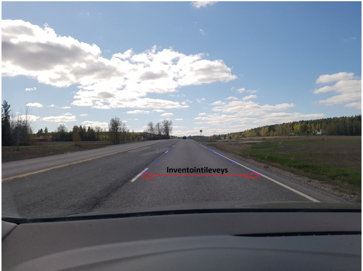
Kuva 15. Yksiajorataisen tien inventointileveys, jossa ohituskaista.
