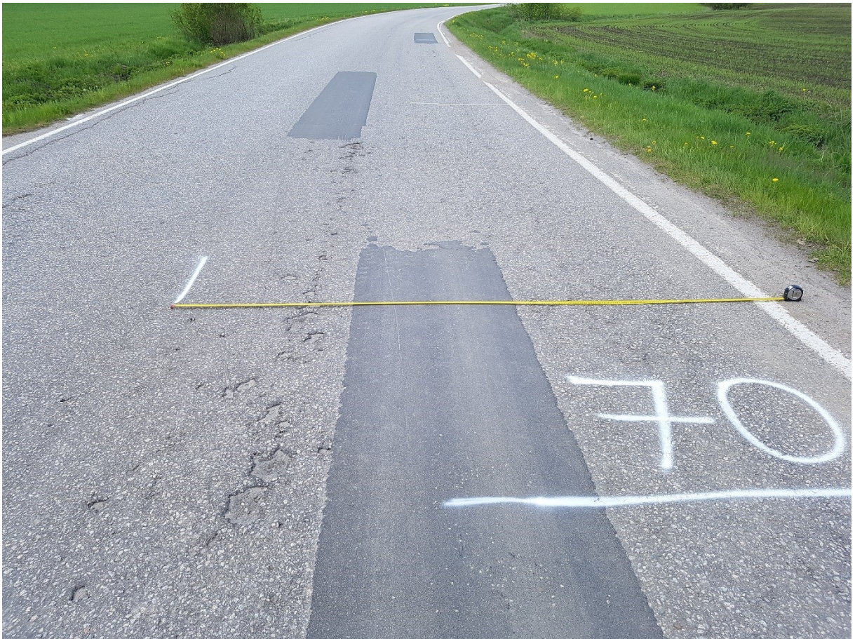
Kuva 28. Tien kaistanleveyden tarkastus mittaamalla.
