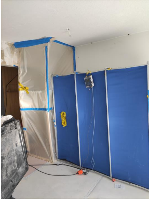
Kuva 2. Asbestiosasto ja sulkutunneli.
