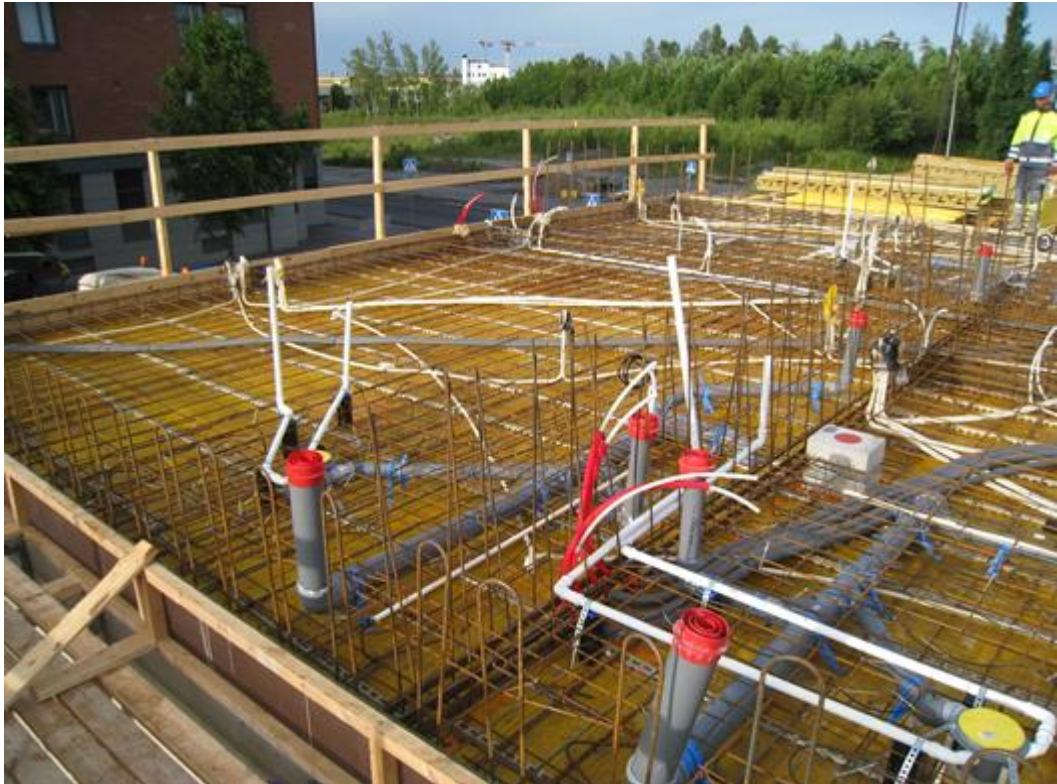
Kuva 5. Holvirakenne ennen betonointia.
