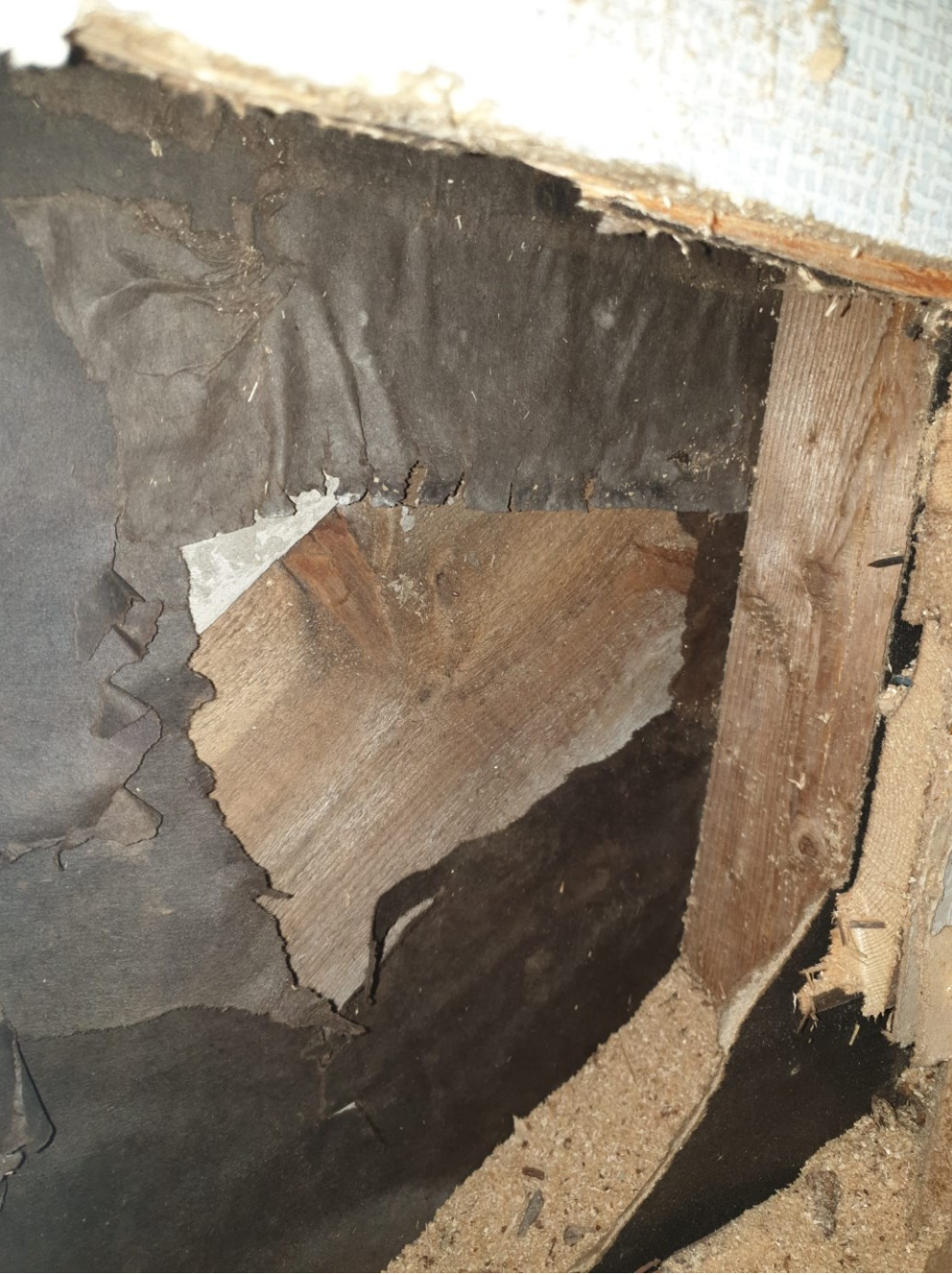
Kuva 10. Ulkoseinän avaus sisältä.
