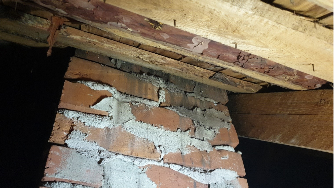
Kuva 18. Savupiipun läpivienti yläpohjassa.
