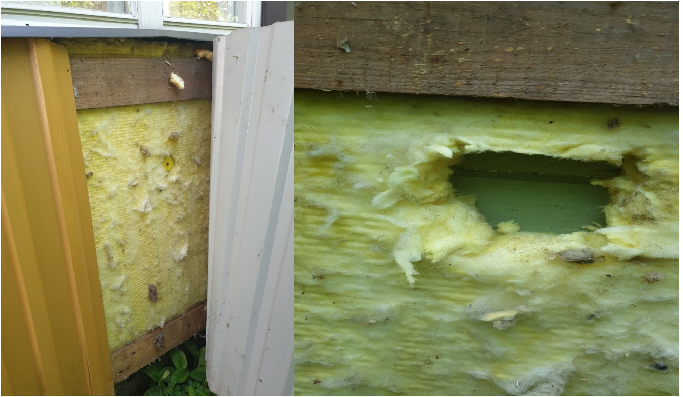
Kuva 11. Talon ensimmäisen kerroksen ulkoseinän rakenneavaus.
