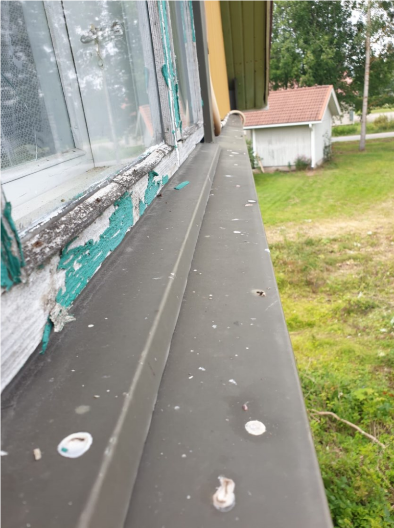
Kuva 15. Toisen kerroksen ikkunan alareuna.
