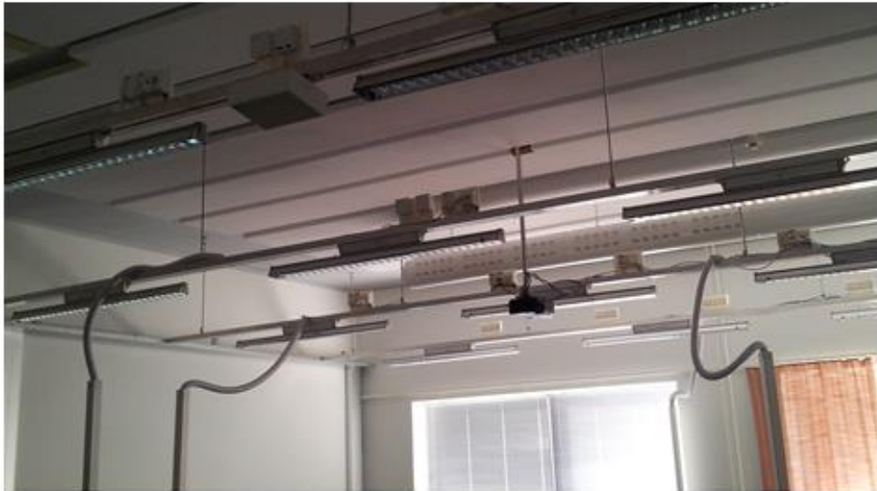
Kuva 20. B244:n muutostyöt kuvattuna ovelta.
