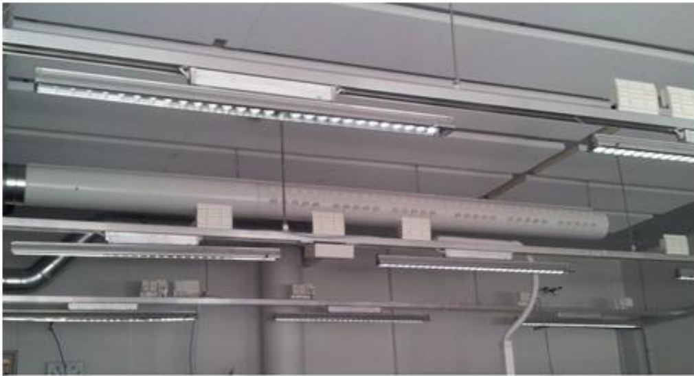
Kuva c) Luokka B244 muutostöiden jälkeen.
