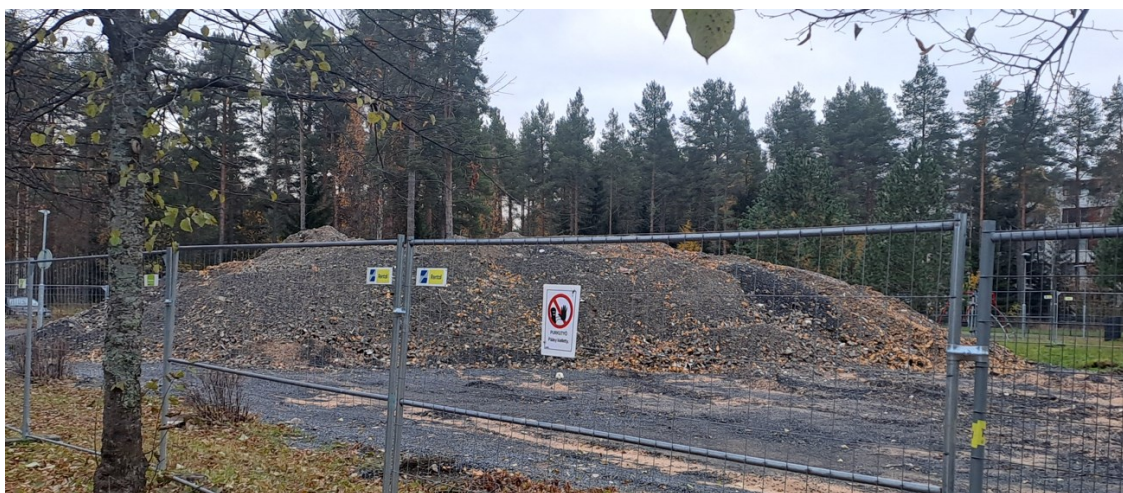
KUVA 7. Purkukohteen betoni- ja tiilijäte kasa
