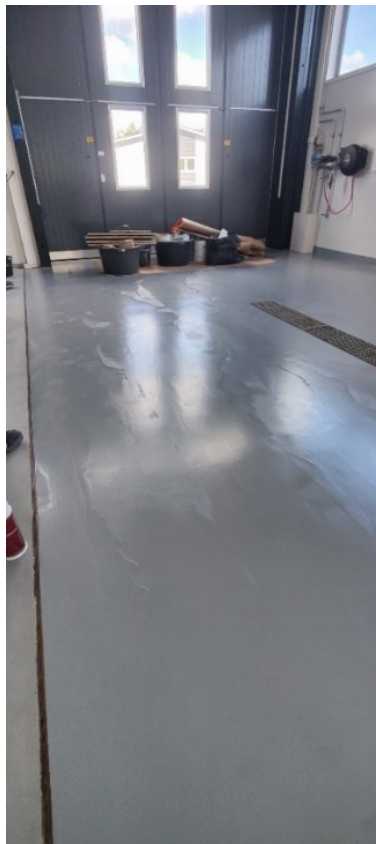
Kuva 7 Uuden pinnoitteen ensimmäinen levityskerta paloaseman hallin lattiaan
