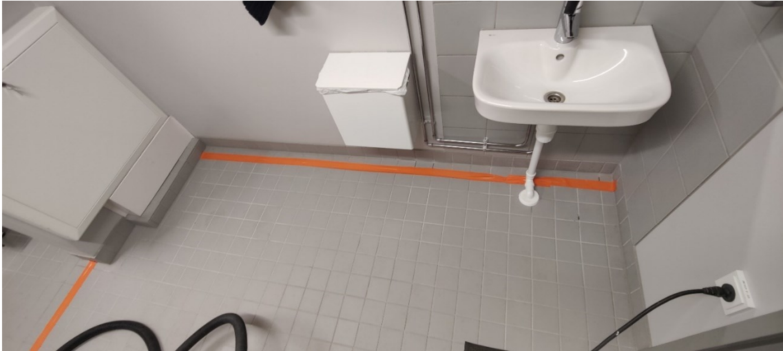
Kuva 13 Haljenneen laattasauman rappaus, tiivistys ja täyttötyö
