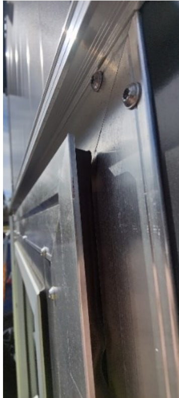
Kuva 19 Vesilaitoksen hallinoven säätö ja tiivisteet
