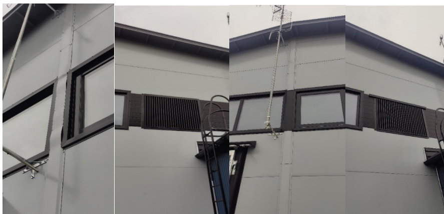
Kuva 25 Kahden pellityksen korjaustyöt
