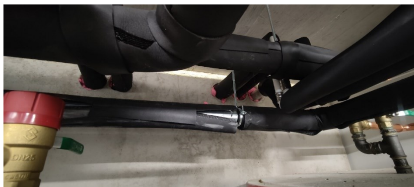
Kuva 16 Palokatkojen lisäykset lämmönjakohuoneen ahtaimpiinkin läpivienteihin
