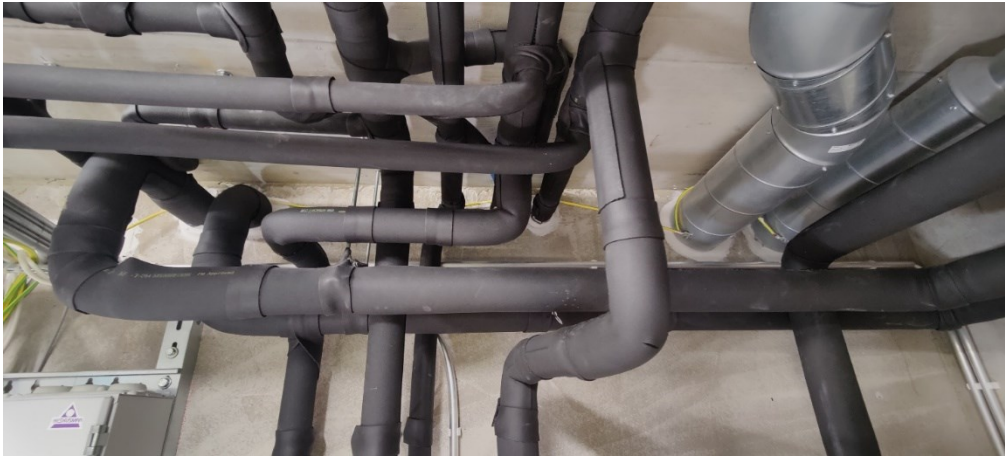
Kuva 17 Lämmönjakohuoneen läpivientien loput täytöt paloakryyllilla
