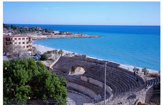
Kuva 10. Amfiteatteri (Puerto de Tarragona 2012)
