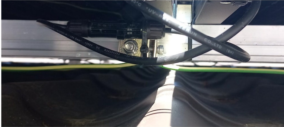
Kuva 12. Paneelin asennustelineen potentiaalintasausliitos.
