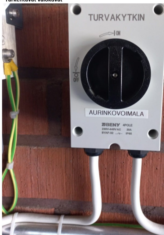
Kuva 11. Invertterin liittäminen potentiaalintasaukseen keltavihreillä potentiaalintasausjohtimilla.
