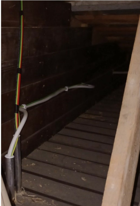
Kuva 8. Vaihtosähköpuolen johdotus
