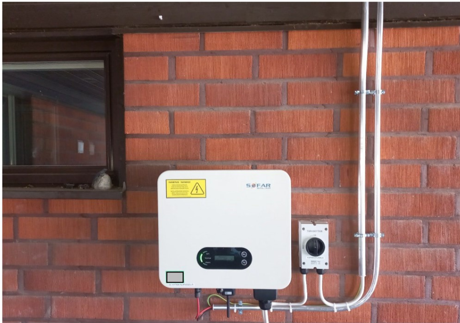
Kuva 7. Yleiskuva invertterin asennuksesta
