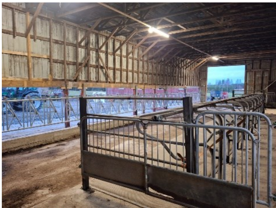
Kuva 13. Umpinainen lantakäytävä ja kolmas makuuparsirivi.
