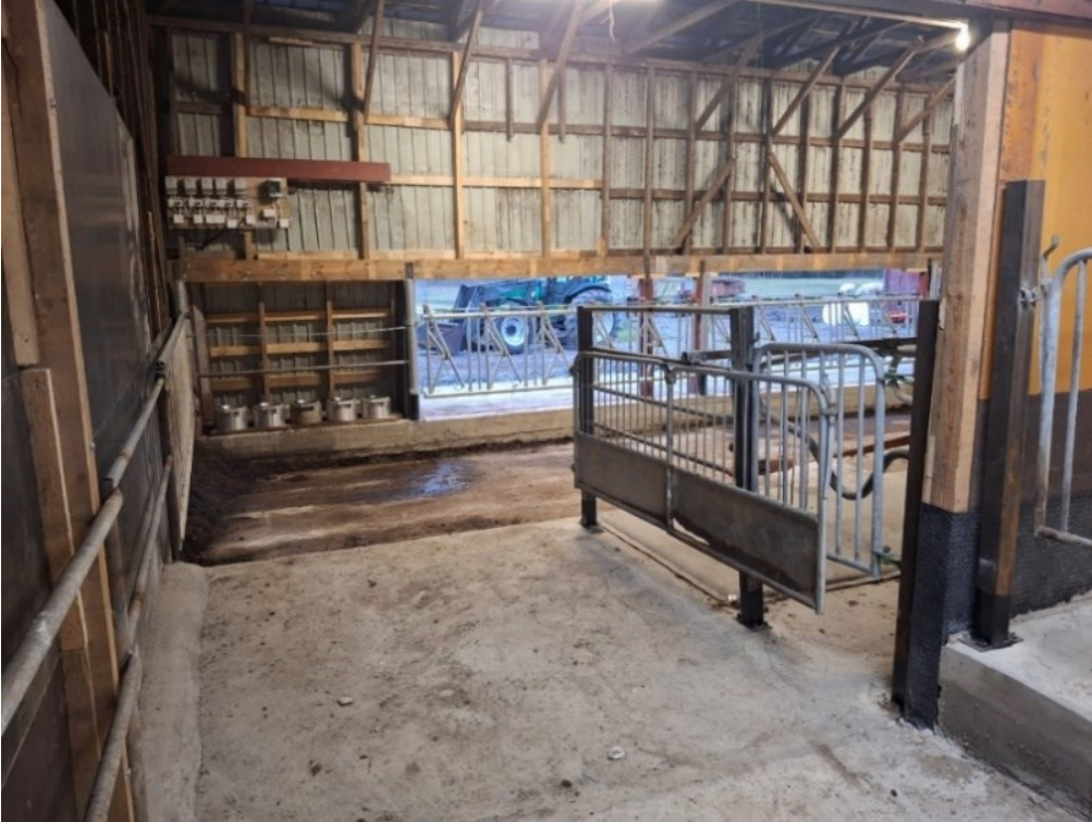
Kuva 14. Toinen poikkikäytävä sekä vesikupit.
