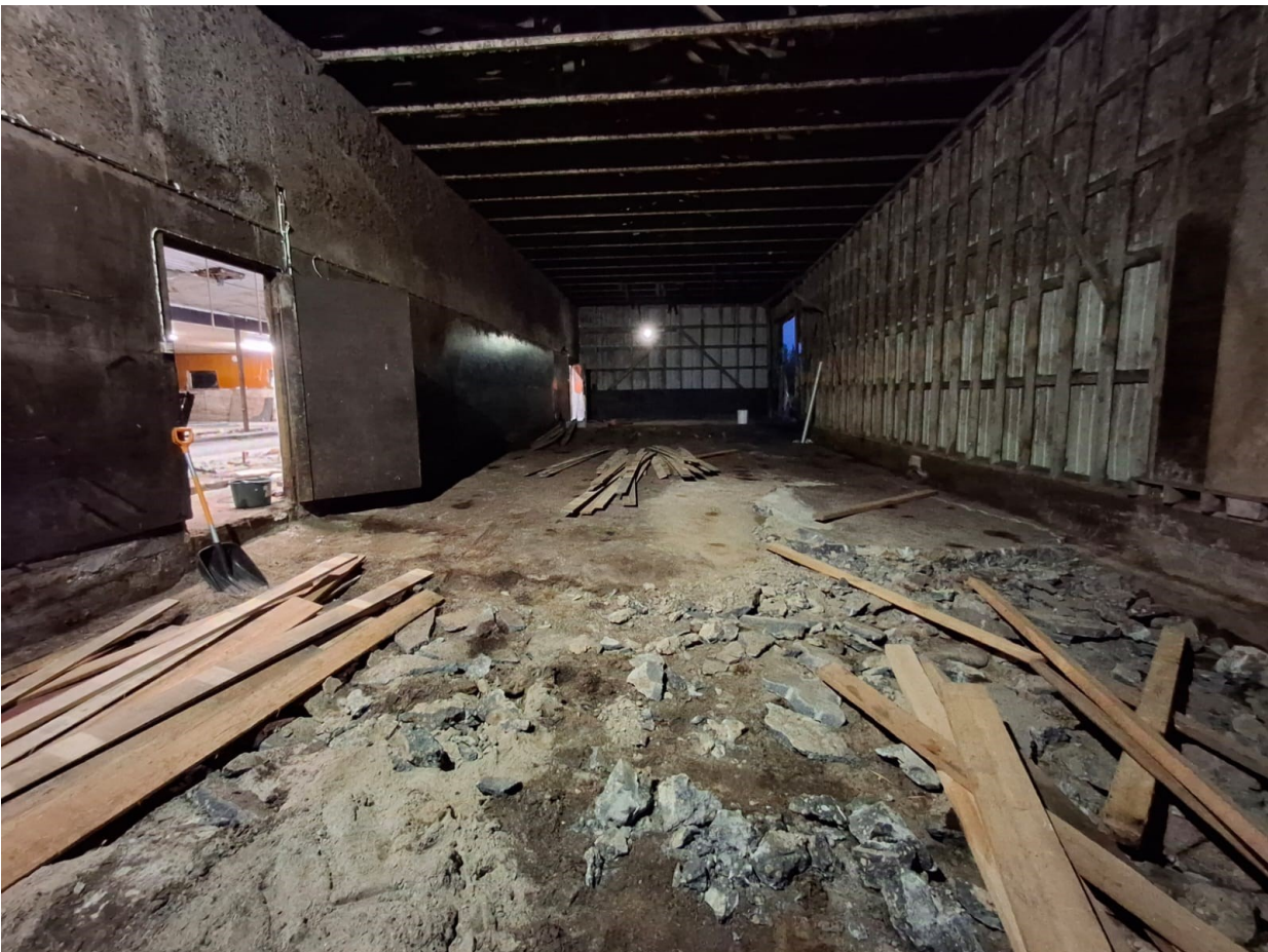
Kuva 2. Kuivike- ja korsirehuvarasto purkutöiden jälkeen.
