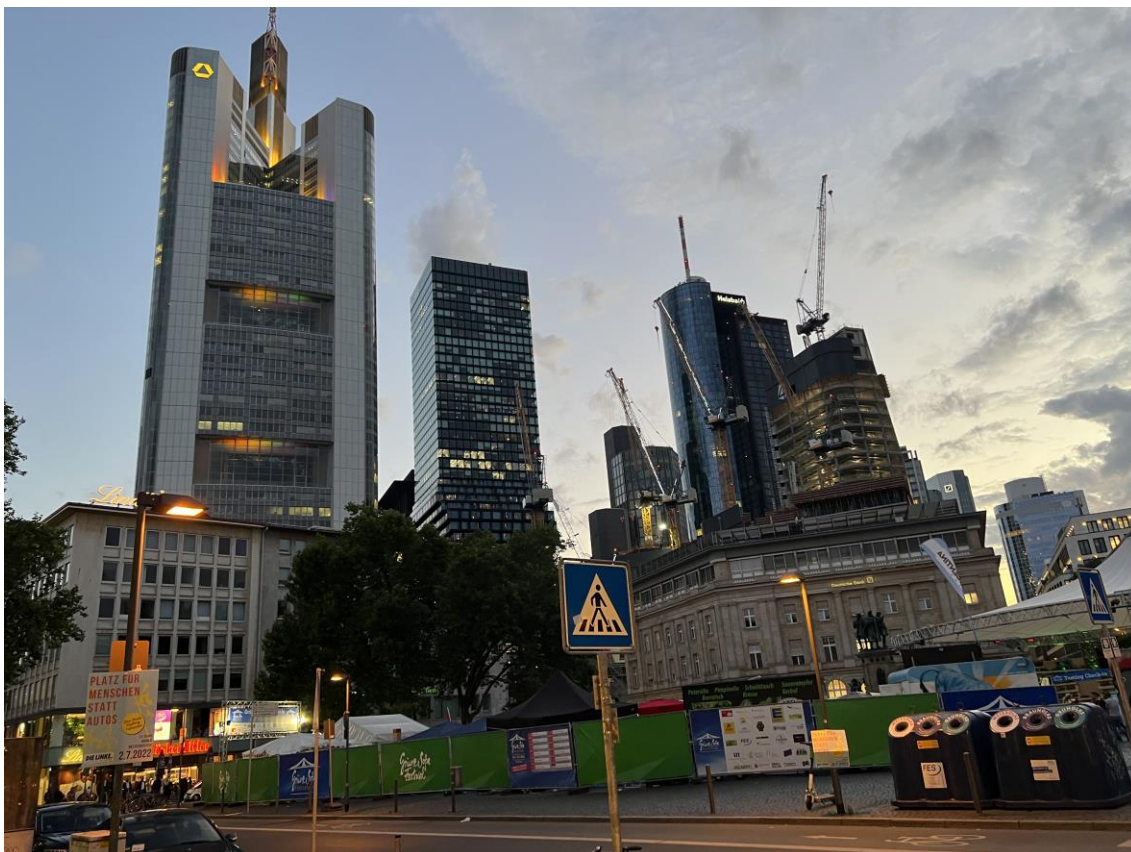
Kuva 3 Korkea rakennus rakenteilla Frankfurtissa, Saksassa. Suomessa vastaavan mittakaavan korkeita rakennushankkeita on toteutettu vielä vain harvoin. (Oma kuva 2022.)
