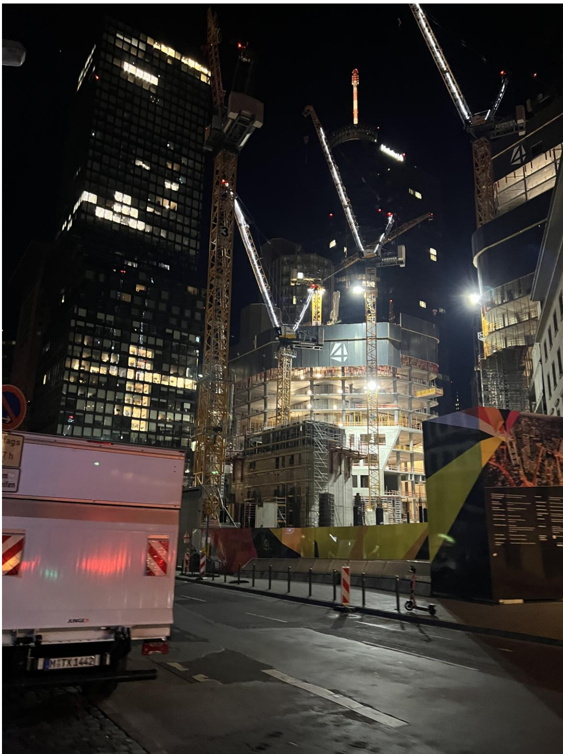
Kuva 4 Valaistu korkea rakennus Frankfurtissa, Saksassa, yöaikaan. Rakennustyömaiden riittävä valaistus on tärkeää työturvallisuuden kannalta, erityisesti korkeissa rakennushankkeissa, joissa työskentely tapahtuu myös ilta- ja yöaikaan. (Oma kuva 2022.)
