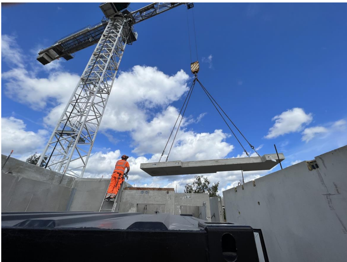
Kuva 1 Asuinrakentaminen kerrostalon elementtipystytys Nokialla (Rakennusliike Etuputsarit Oy 2022)
