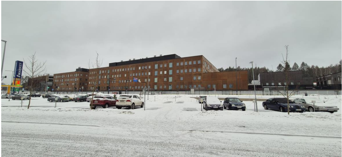
Kuva 18. Ahveniston sairaalan työmaa sisärakennusvaiheessa. (Oma kuva, 2025.)
