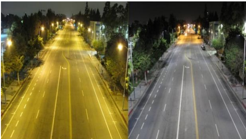
Kuva 7. Los Angeles, Hoover Street. Vasemmanpuoleisessa kuvassa katu on valaistu suurpainenatriumlampuilla ja oikeanpuoleisessa kuvassa sama katu on valaistu led-katuvalaisimilla. (Cleantechnica.com 2013.)
