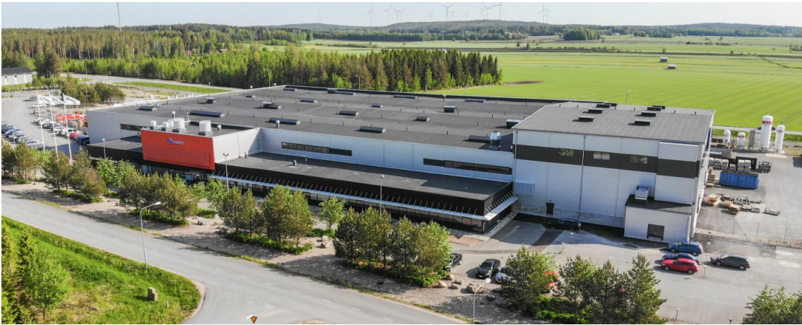
KUVA 1. Relicomp Oy:n toimitilat Kurikassa (Relicomp 2023).
