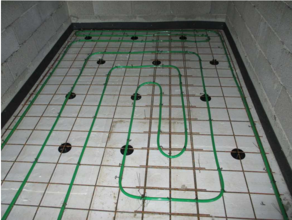
Kuvio 3. Lattialämmityspotkisto ennen betonointia
