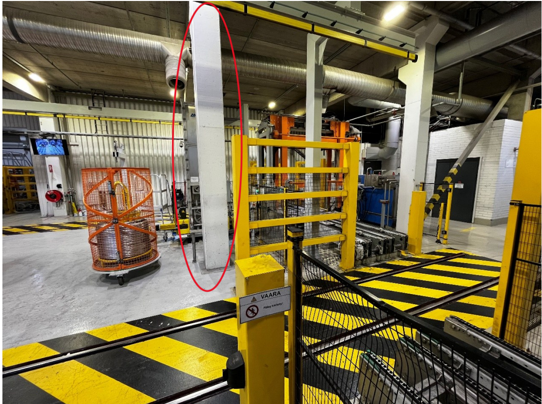
Kuva 16. Betonipilari, jonka takia yksiköinti 2 siirretty sivumpaan, vaikka todellisuudessa olisi mahtunut sen viereen ja saada kuljettimien linja suoraksi.
