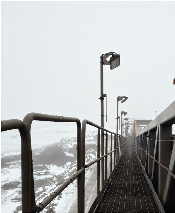
Kuvio 18. Valokuva vanhan kuljettimen valaisinasennuksesta
