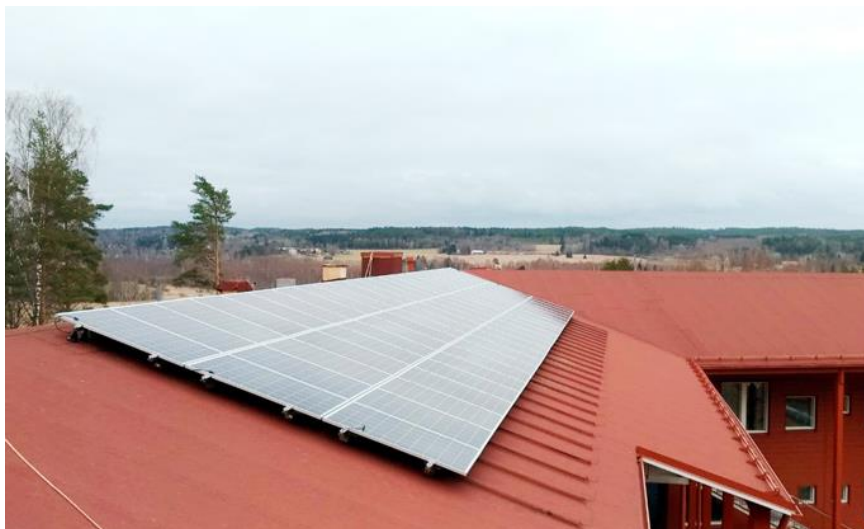
Kuva 15. Aurinkopaneelikenttä jyrkällä katolla lappeen suuntaisesti (Orima-Tuote, n.d.)
