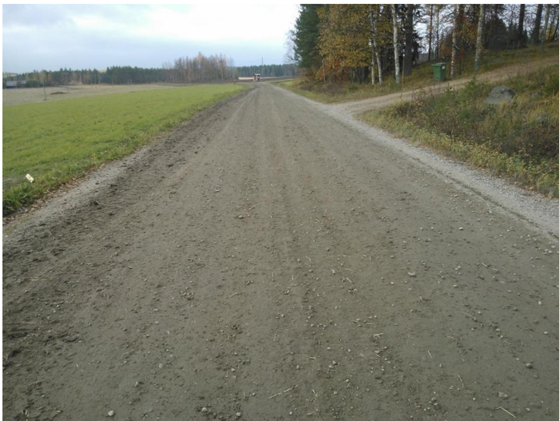
Kuva 9. Tie 15919 Heinäsuo-Jokikylä tie seitsemän vuotta Remix-käsittelyn jälkeen ja muutama päivä pinnan muokkauksen jälkeen.(Vartiainen-2014-10-9)
