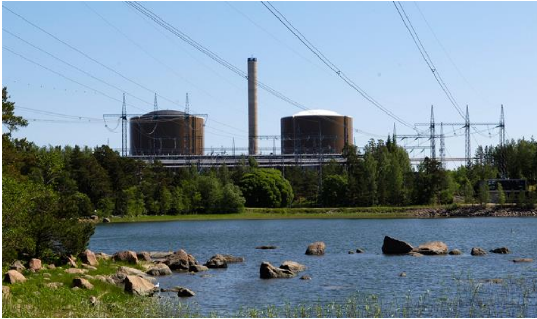
Kuva 1. Loviisan voimalaitos (Työ- ja elinkeinoministeriö 2023)
