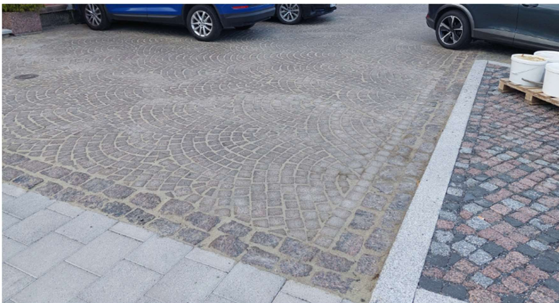
KUVA 4. Epoksi pohjainen saumaus noppakiveyksessä (Kuva: Leevi Nikunoja 2024)
