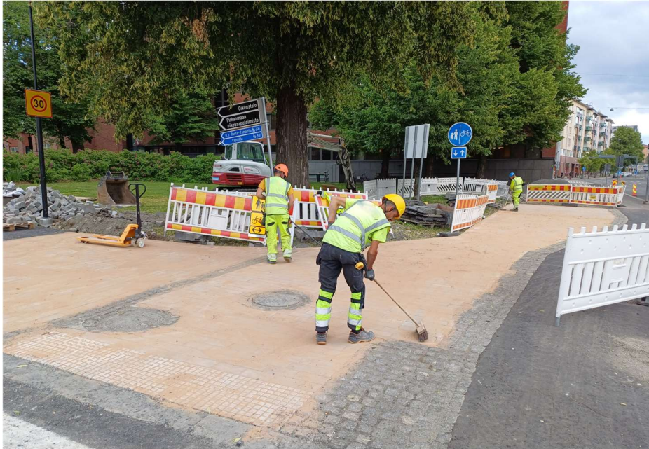
KUVA 3. Betoni laattojen saumaus hiekalla (Kuva: Leevi Nikunoja 2024)
