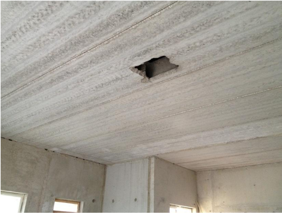
KUVA 22. Ontelolaattaan piikattiin reikä Leca-kevytsorabetonin valamista varten
