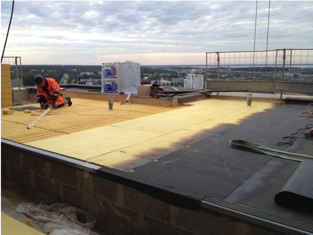
KUVA 7. Pakettikatolle asennetaan lämpö- ja vesieristystä
