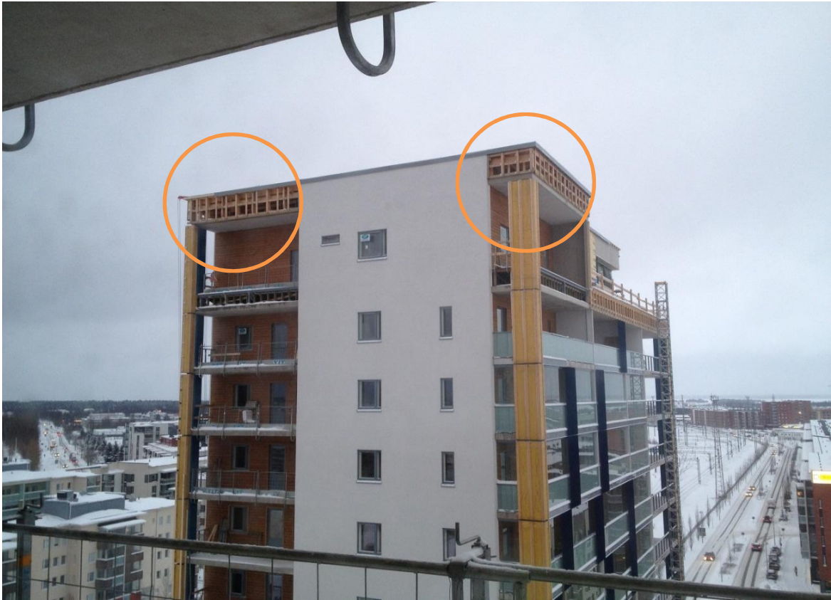
KUVA 21. Parvekkeiden kattojen puurungot tehtiin paikalla rakennettuna
