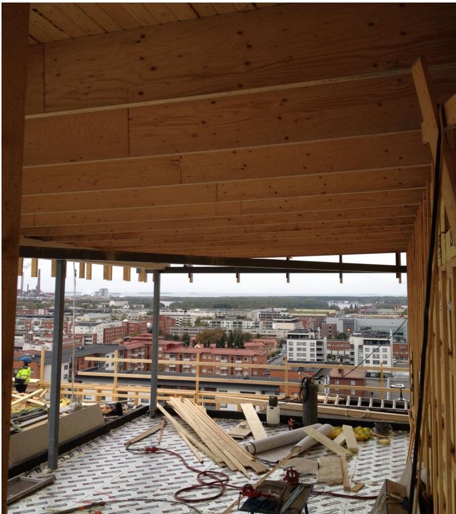
KUVA 20. Teräspilarit kannattelevat teräspalkkeja, joiden päällä on Kerto-S-palkit ja kattolaudoitus
