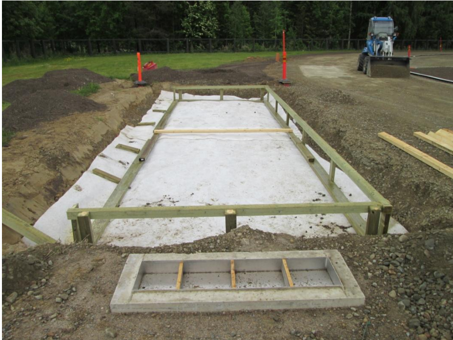
Kuvio 14. Pituushyppypaikan alastulo rakenteilla
