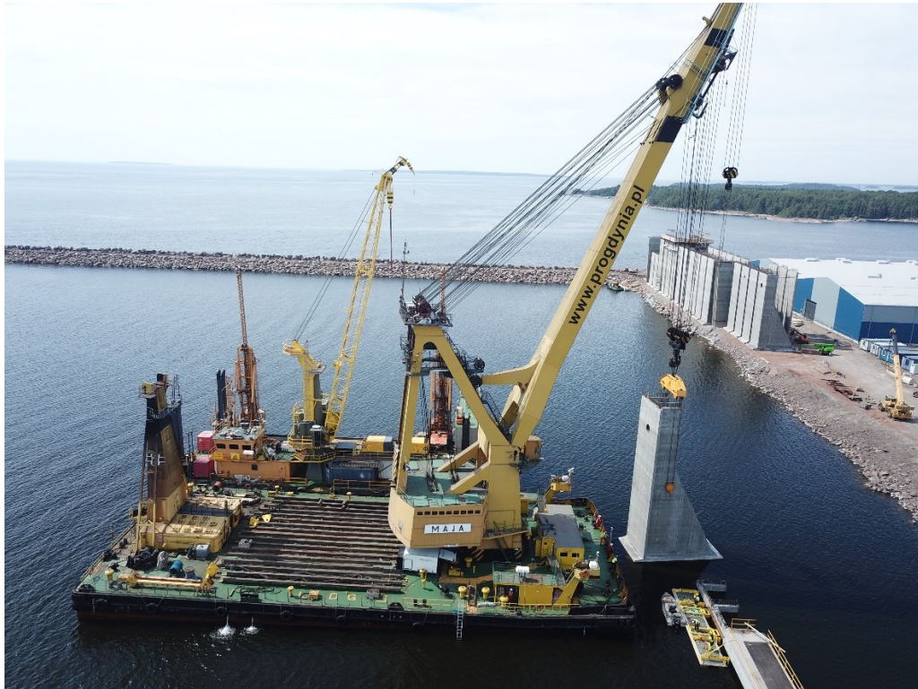
Kuva 13. Elementtien asennus uivalla nosturilautalla (Donner, 2022)
