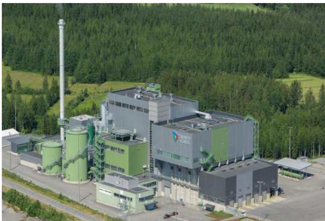
Kuva 2. Tammervoiman hyötyvoimalaitos. (Tammervoima, 2024).
