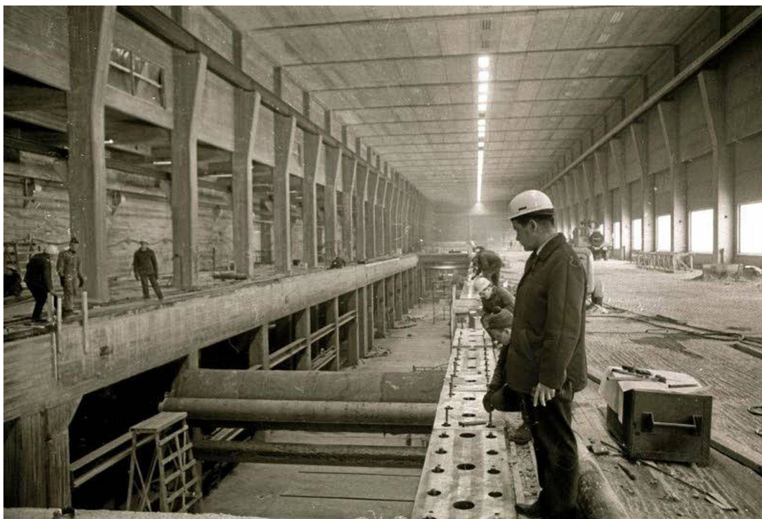
Kuva 1 Kartonkikoneen asennus (Launonen, 2016)
