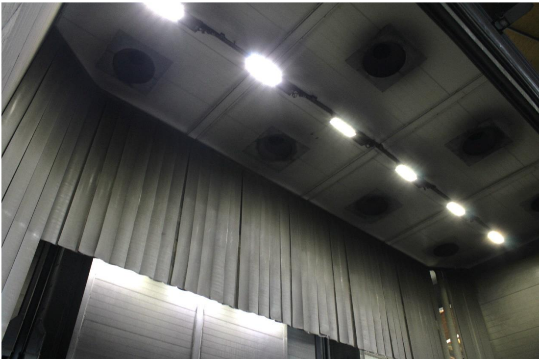
Kuva 29. Kohdennettu pölynpoistojärjestelmä purkumontun yläpuolella (Laine, 2025)
