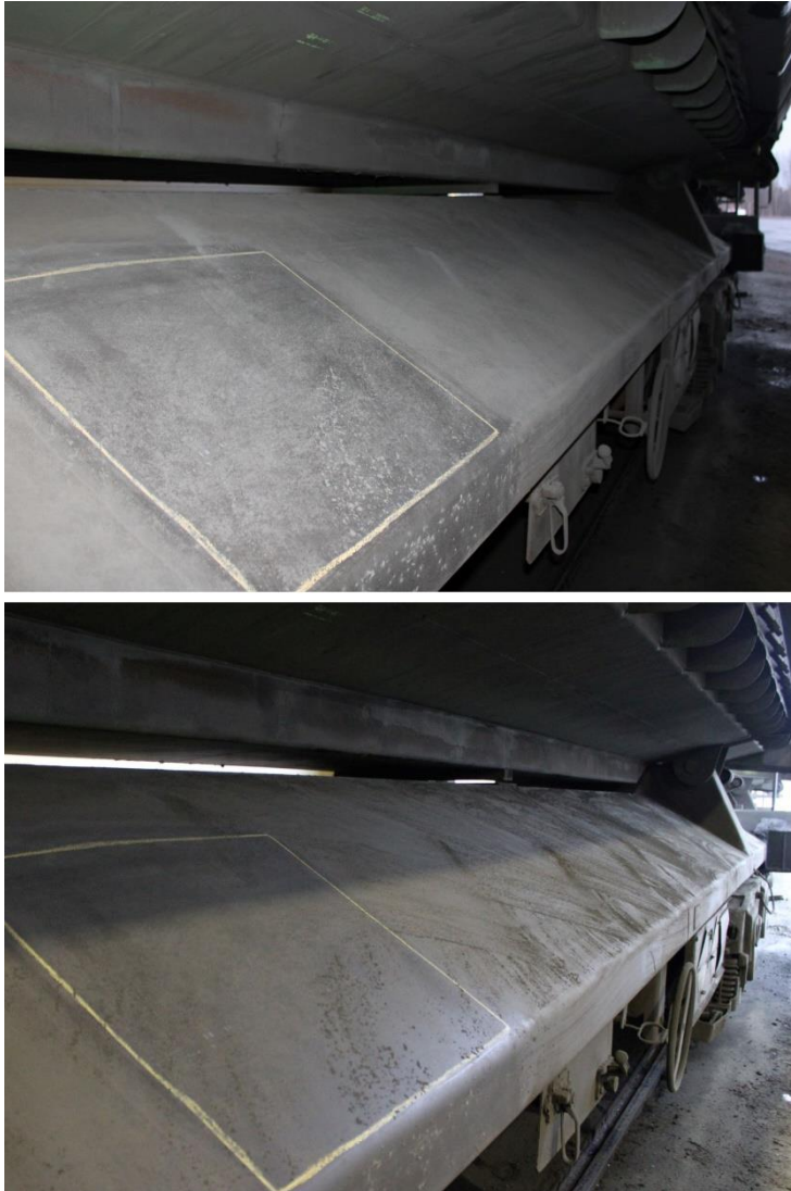
Kuva 20. Lähikuvaa rungosta purkamisen jälkeen (Laine, 2024)
