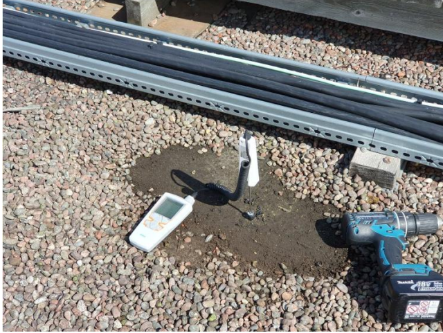
Kuva 14. Kosteusmittaus MMR työmaalta 2023
